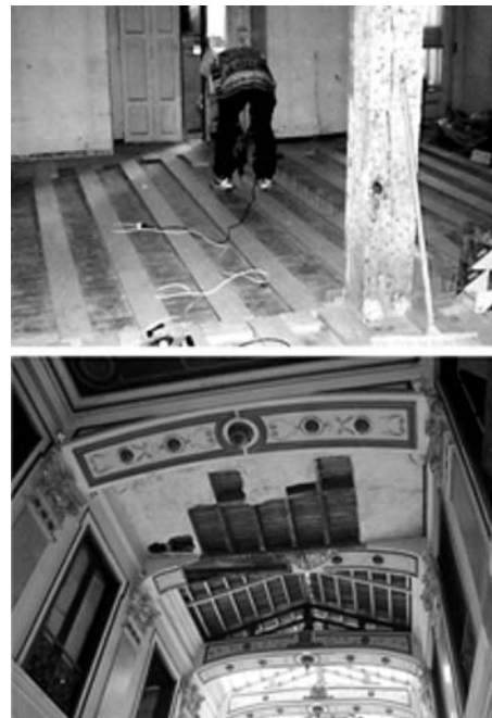
Figura 9. En la rehabilitación es demasiado frecuente tener que trabajar sobre locales en uso, lo que complica la realización de trabajos con seguridad. En el caso del refuerzo de este forjado del pasaje Gutiérrez de Valladolid, mantener la tarima entre los refuerzos de madera microlaminada y las vigas a reforzar, supuso una tranquilizadora garantía de seguridad para los viandantes que seguían transitando por el pasaje. También es ventajoso mantener las tarimas cuando se trata de reforzar forjados con hormigón, ya que sirven de encofrado perdido. Ahora bien en ambos casos es preciso confirmar previamente que el estado de las maderas a reforzar esté libre de ataques de xilófagos que hubieran disminuido su sección eficaz, lo que exigiría levantar, aunque sólo fuera localmente, la tarima que impida trabajar sobre las posibles zonas dañadas. (Edificio de viviendas en el Pasaje Gutiérrez, de Valladolid).
