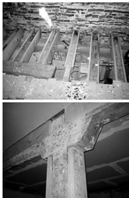
Figura 4. En las estructuras que no han de quedar vistas era habitual la utilización de refuerzos metálicos. Estos pueden seguir siendo válidos, sin embargo, hoy disponemos para este fin también de madera microlaminada, cuyas características son muy ventajosas a la hora de realizar refuerzos. No obstante seguiremos necesitando tornillos o bulones de acero, que en determinados casos son más fáciles de utilizar que las uniones encoladas cuya ejecución requiere la intervención de carpinteros cualificados. (Edificio de viviendas en el Pasaje Gutiérrez, de Valladolid).
