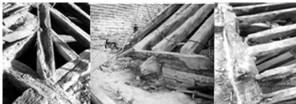
Figura 3. Salvo que se trate de defectos debidos a un inadecuado diseño, los daños en la madera siempre son el resultado de la acción de los xilófagos como consecuencia de haber estado la madera con un contenido de humedad por encima del 20%. En las cubiertas que hayan carecido de un eficaz mantenimiento es lógico que esos daños aparezcan junto a los estribos, donde por lógica acaba acumulándose el agua de las posibles goteras. (Cubiertas de la iglesia del convento de las Comendadoras de Madrid).
